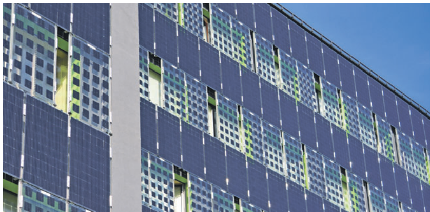
Photovoltaikanlagen findet man nicht nur auf Dächern, diese können auch an der Gebäudehülle eingesetzt werden. (Foto: Shutterstock)
