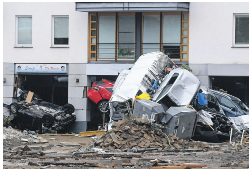
Schäden nach dem Hochwasser im Juli in Bad Neuenahr-Ahrweiler in Deutschland. (Foto: RM)
